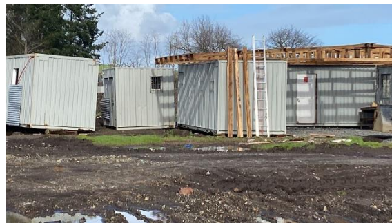
Área central del Hospital de Nacimiento. Trabajos de Acopio de Contenedores Instalación de Faena
