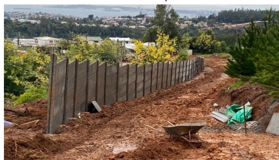
Cierro Perimetral con pandereta. Hospital de Lota
