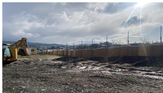
Cerramiento Perimetral. Hospital de Nacimiento
